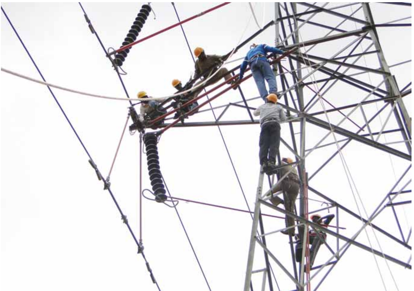
Replacement of 220KV sus string
